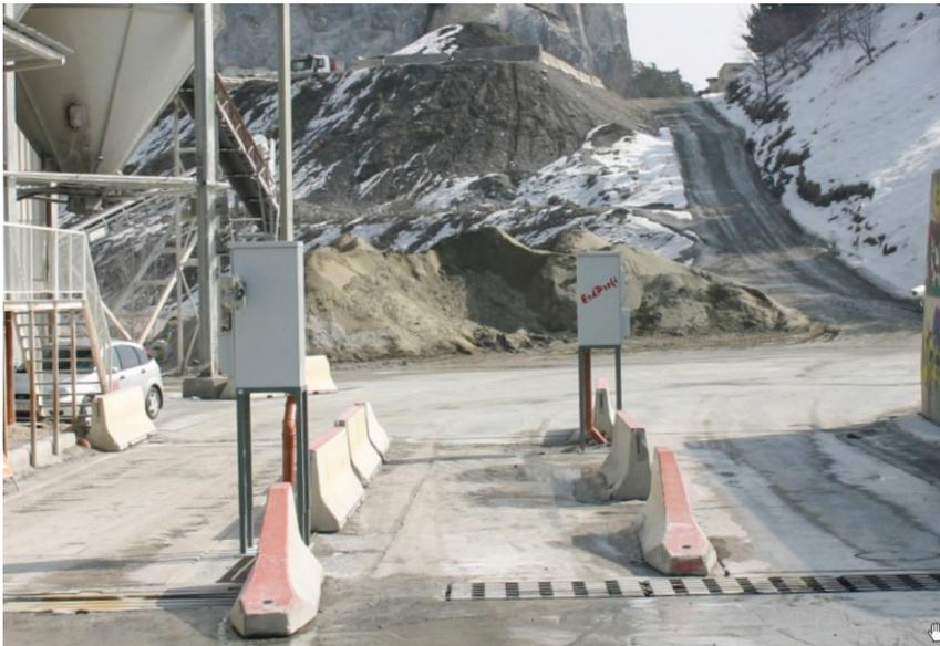
**Anlage von Fa. Plattner in Zirl. Einfahrts- und Ausfahrtswaage sind zwei getrennte Brückenwaagen. Links: Einfahrtswaage. Rechts: Ausfahrtswaage mit Kamera für Kennzeichen.**
